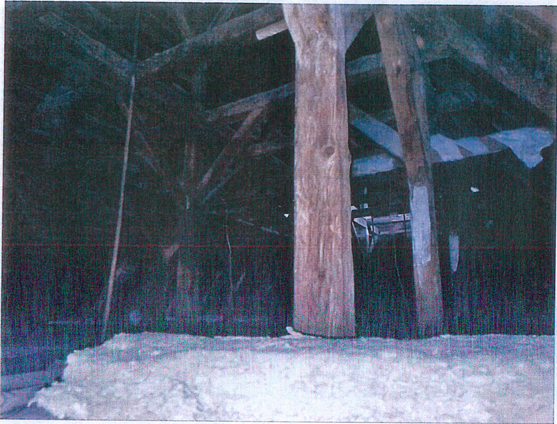
Fot.2. Widok drewnianej konstrukcji wieży kościoła w Bobrownikach, nie stwierdzono ugięć, załamania lub innych uszkodzeń świadczących o braku stateczności konstrukcji.
