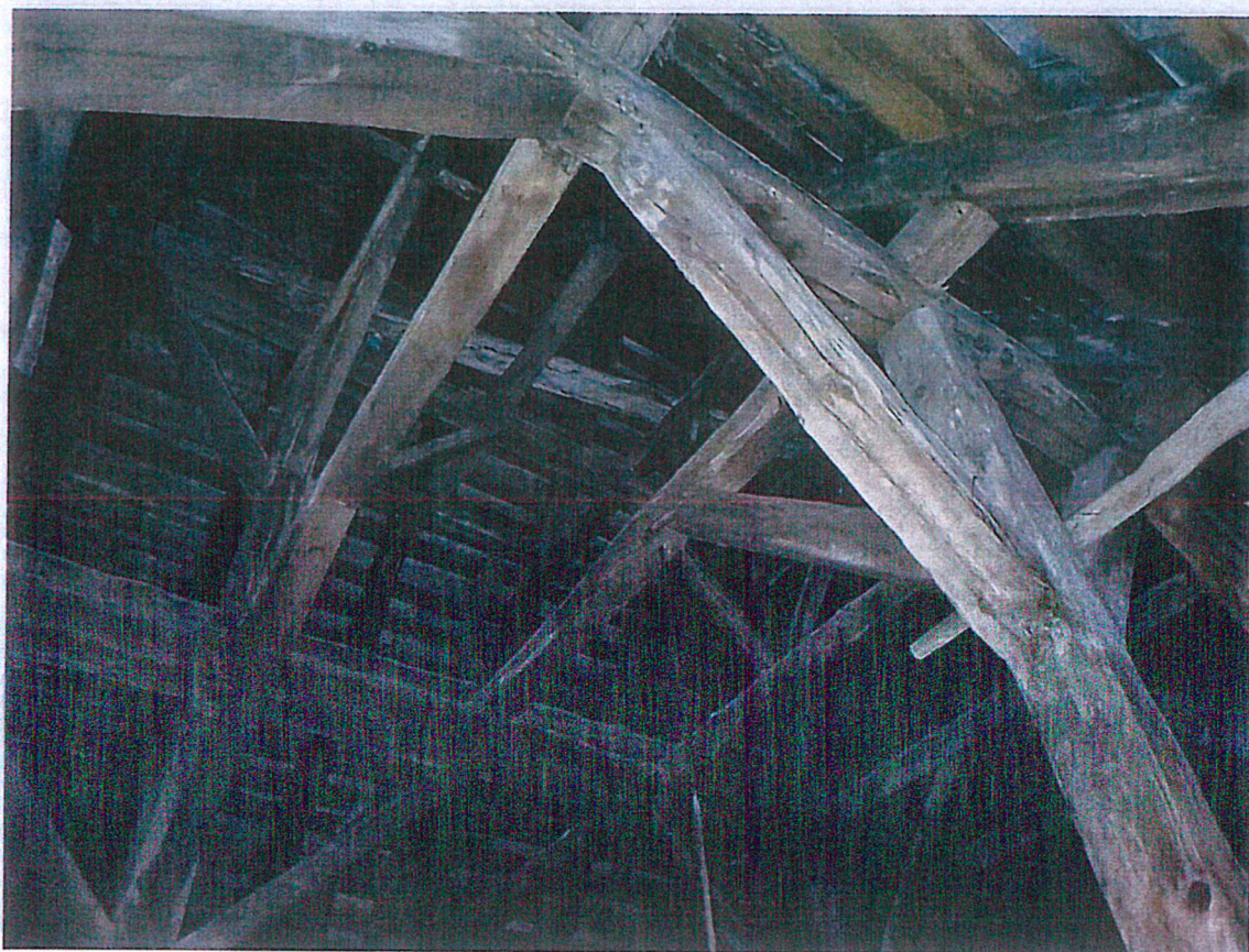
Fot.4. Brak ugięć, załamania lub innych uszkodzeń świadczących o braku stateczności więźby dachowej.
