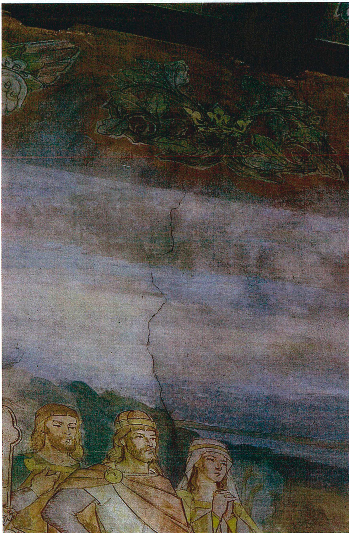
Fot.15. Rysa na fresku ściany północnej widoczna wewnątrz świątyni.
