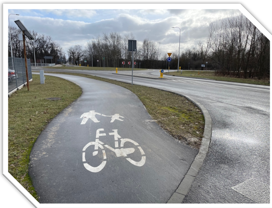
Fotografia 5. Infrastruktura rowerowa w mieście Dęblin
