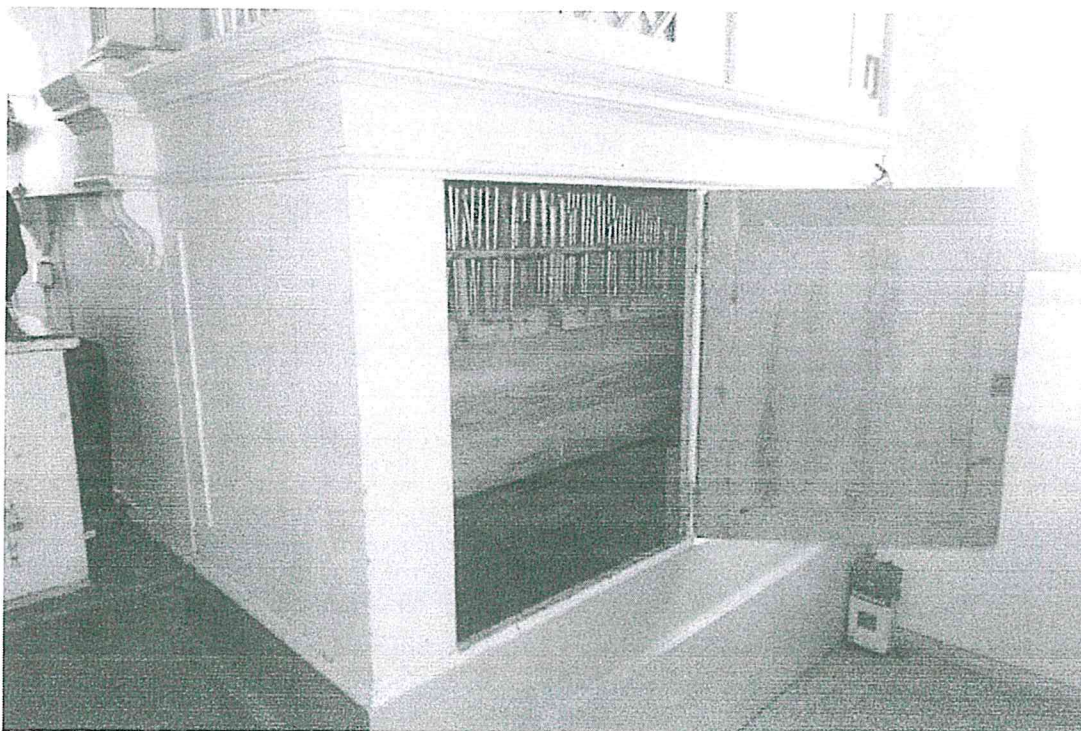
Fot. 10. Widok na wejście do wnętrza szafy – widoczna wiatrownica manuału.
