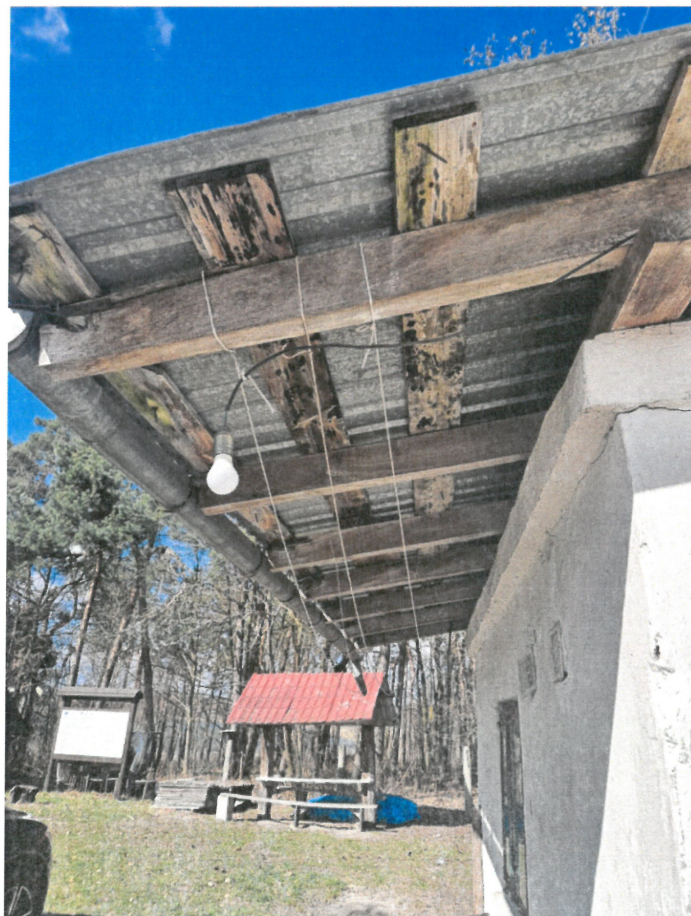
Rys. 4 Skorodowana biologicznie więźba dachowa
